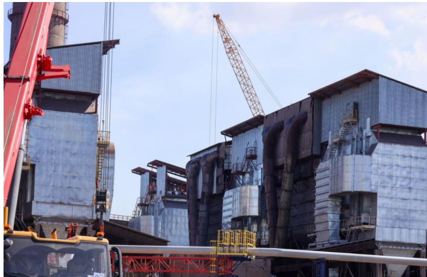
В 2024 завершены работы по реконструкции 5-ти электрофильтров системы очистки аспирационного воздуха в АГЦ-3 (заменены э/ф № 1,2,9, 11, 12)
