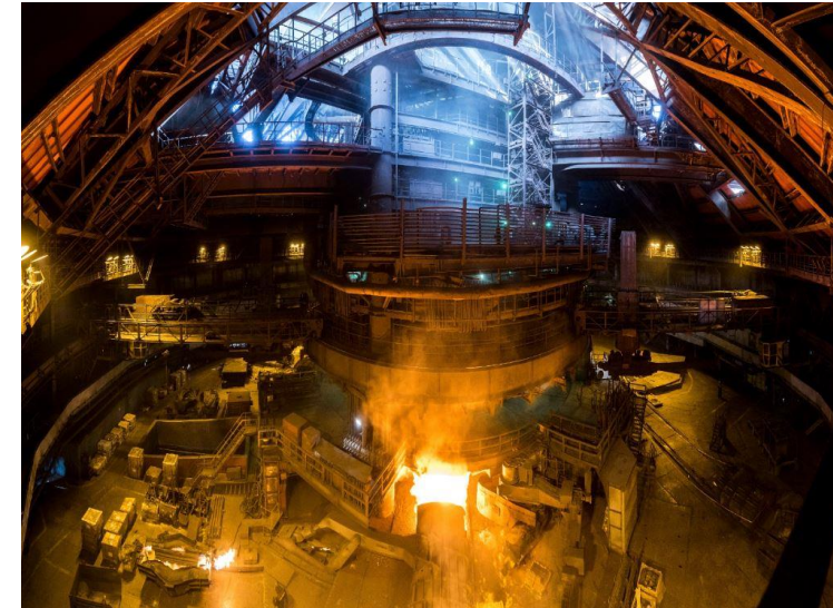
В 2024 г. выполнено техническое перевооружение доменной печи №5 «Северянка»
