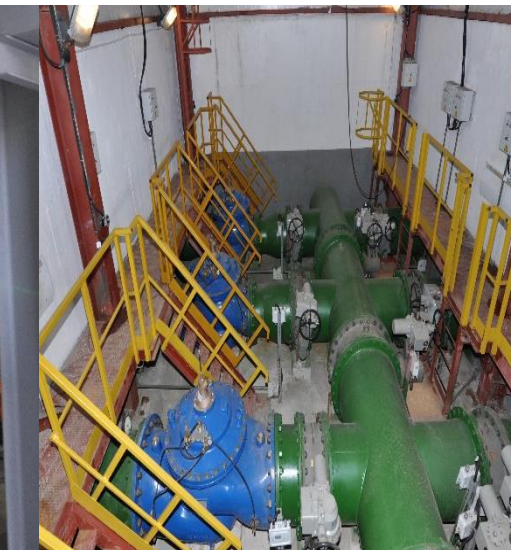
Строительство насосной станции перекачки стоков при опорожнении трубопроводов осветленной воды на ЗШН №1
